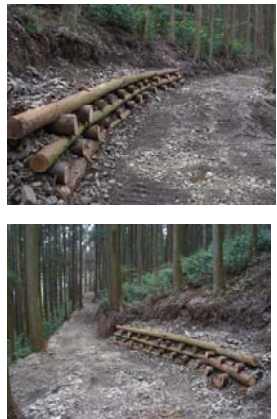
丸太組を施工
